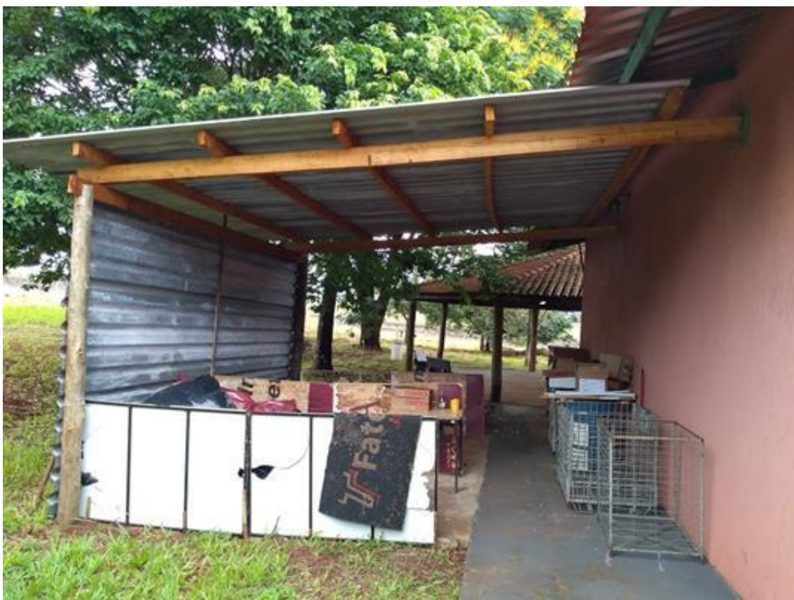
Figura 1- Local de Armazenamento temporário dos resíduos recicláveis da Fatec Jahu.
