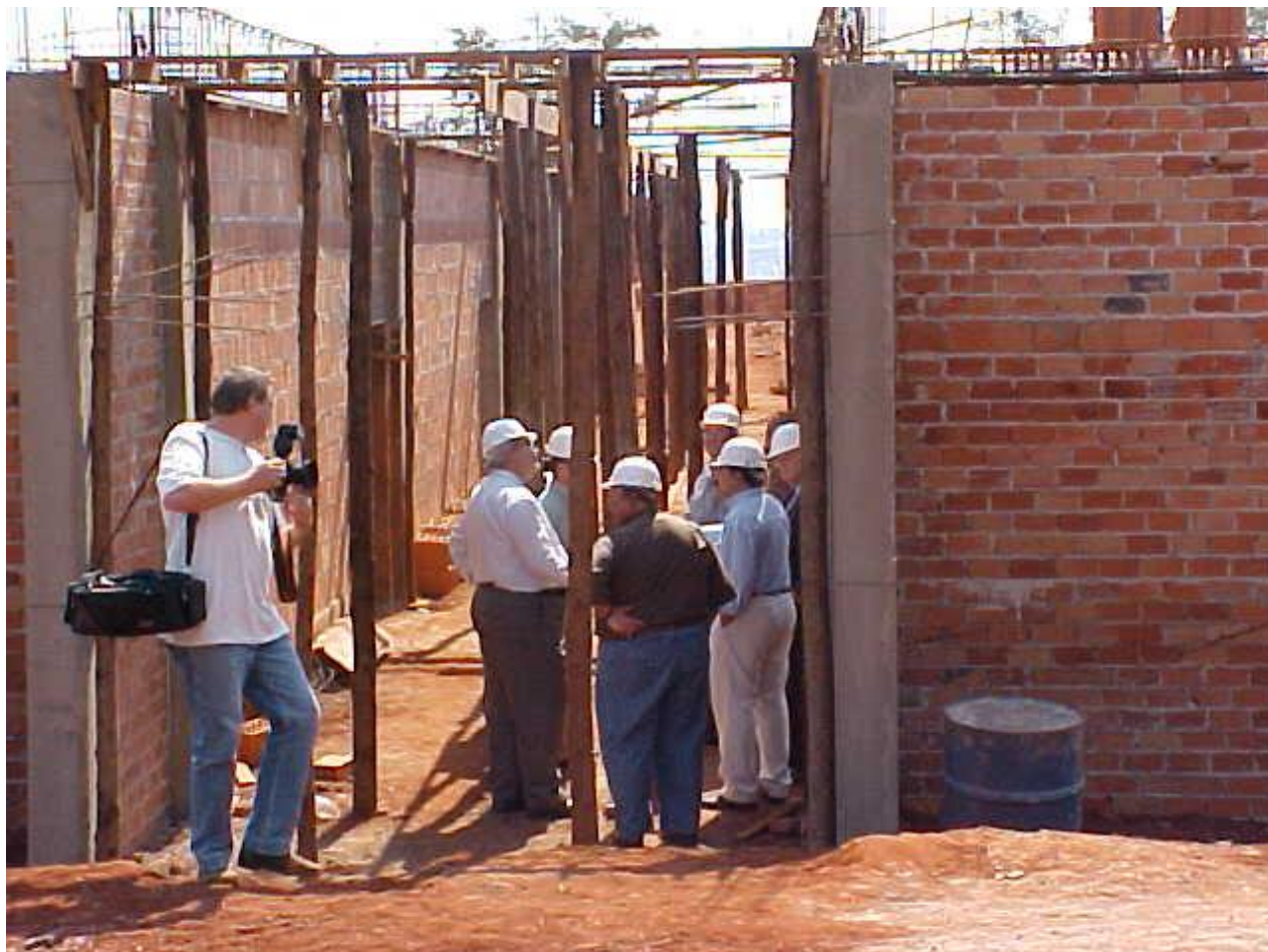
Figura 9 – Foto do Bloco II em fase de construção
