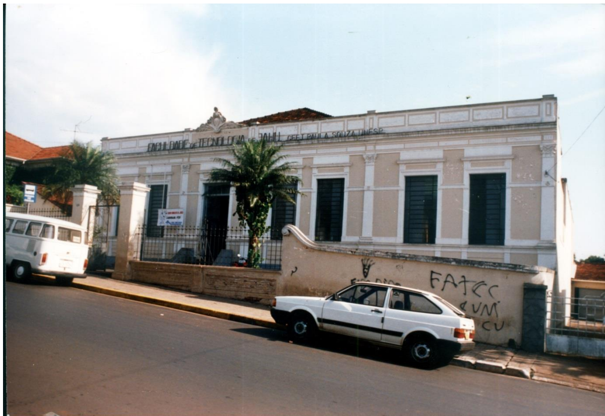
Figura 1 - Prédio onde foi instalada a Fatec Jahu
