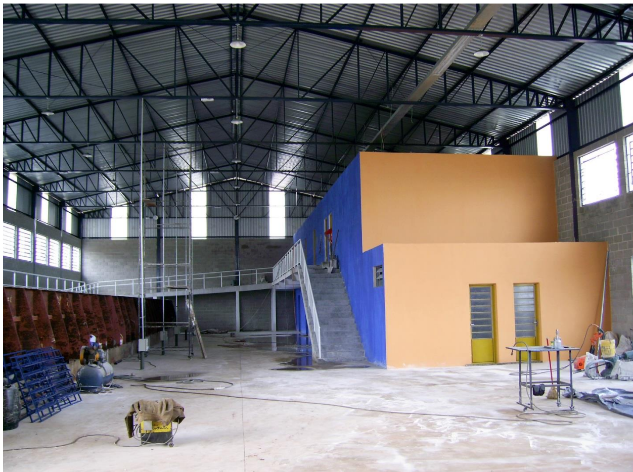
Figura 13 – Foto do Estaleiro Escola em fase de construção
