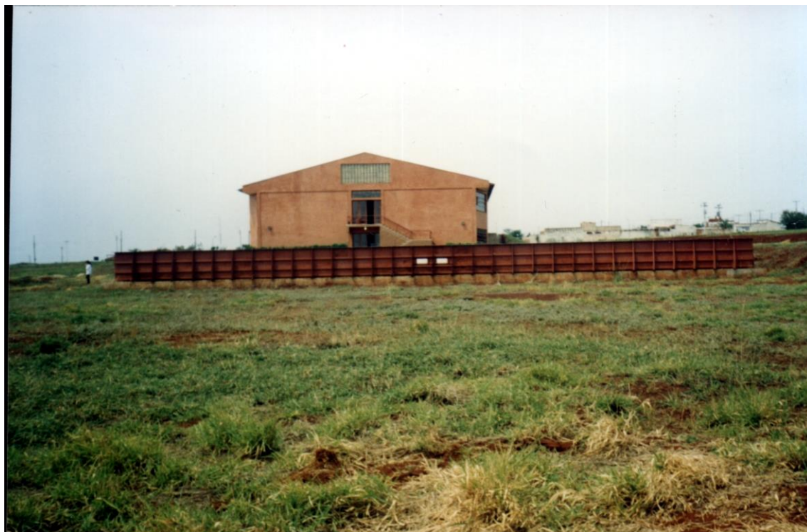
Figura 19 – Foto do Tanque de Provas e o Bloco I
