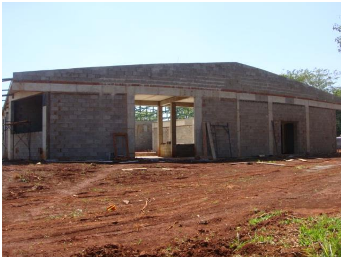
Figura 23 - Foto do Bloco III em construção
