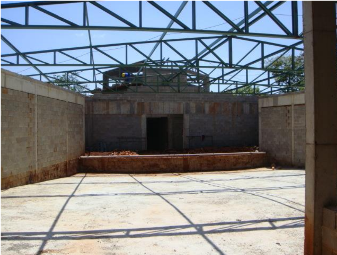
Figura 24 – Foto do Bloco III em construção
