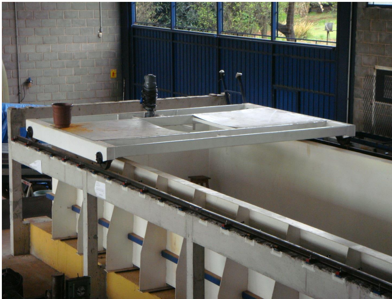
Figura 20 – Foto do Tanque de Provas em fase de instalação
