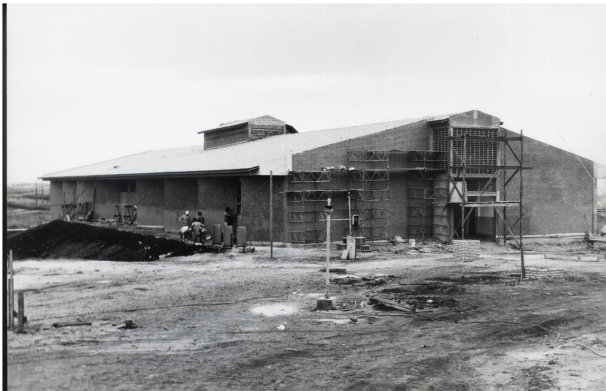
Figura 5– Foto do Bloco I em fase de construção
