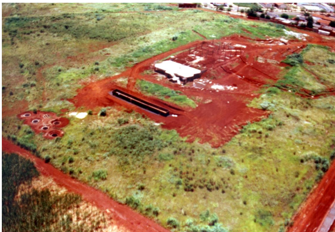
Figura 4 - Foto do Bloco I no início da construção
