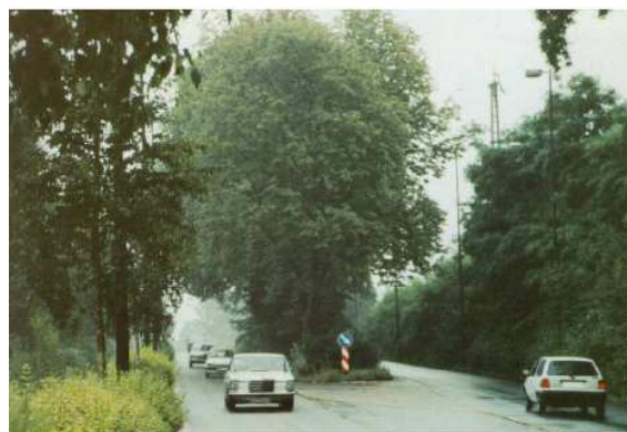
Fonte: (BHTrans, 2000, p. 91) Figura 7 - Canteiro central com vegetação contribuindo para o efeito de "largura ótica" (Foto: Hass-Klau et Al)
